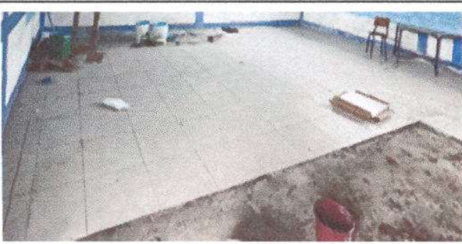
Foto 3: sustitucion de piso de ceramico
