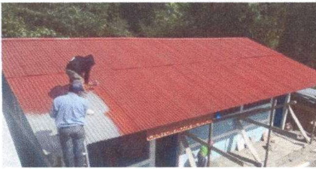
Foto1: En proceso a mantenimineto a estructura de soporte de metal
