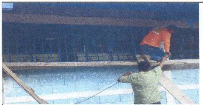
Foto 5: fabricacion e instalacion de balcon de metal
