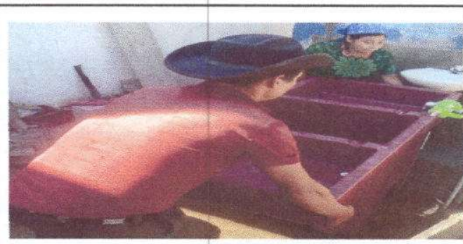
Foto 6: Instalando pila plastica de dos lavaderos
